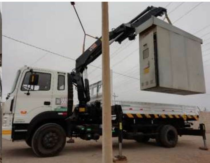
Montaje y desmontaje de celdas.
