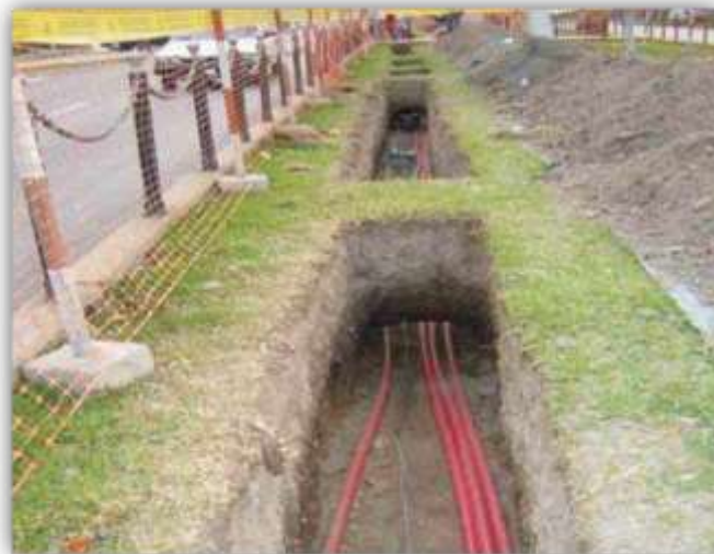
Tendido subterráneo de líneas de media tensión.
