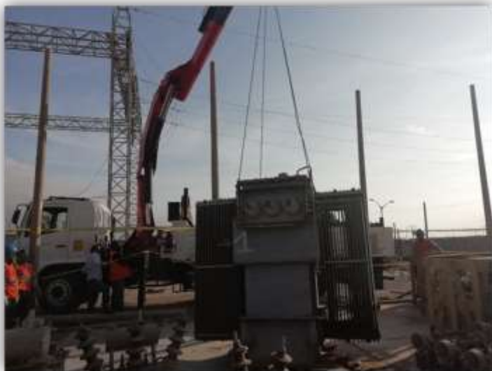
Montaje y desmontaje de transformador de potencia.
