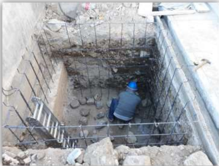
Construcción de buzones para líneas de
