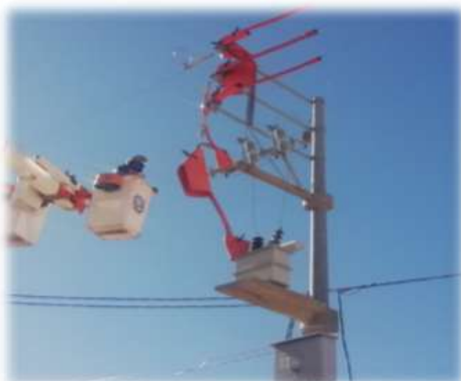
Maniobras en líneas energizadas.
