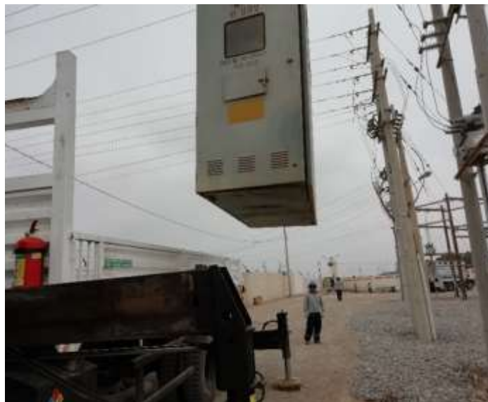
Montaje y desmontaje de celdas.
